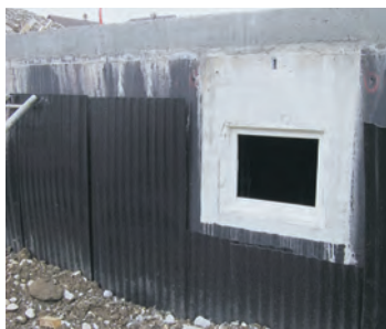
Sofern nur eingeschossig in den Boden hinabgebaut wird und es sich um normales Auffüllmaterial handelt, kann auch der leichtere Typ REPLAST «L» eingesetzt werden.
