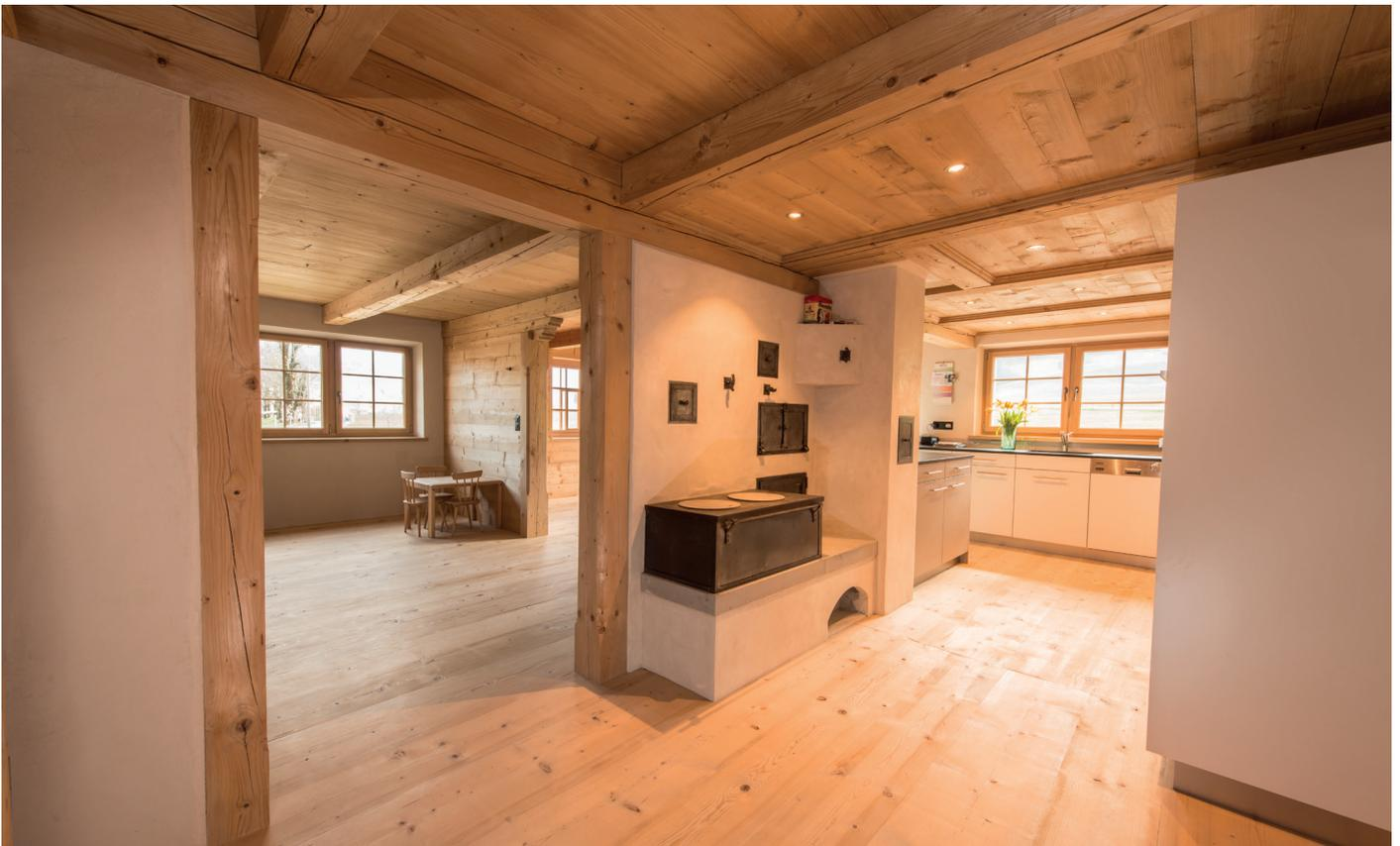
Bei diesem Neubau wurden sämtliche Holzeinbauten in altertümlicher Bauweise umgesetzt, doch statt Altholz wurde stets Retro-Holz verwendet. Decken und Wände bestehen aus handgehobelten Retro-Holz Klotzbrettern, für Pfosten und Balken wurde Retro-Bauholz benutzt. Kombiniert mit speziellem Verputz entstand der Charme der Vergangenheit in neuem Gewand.
